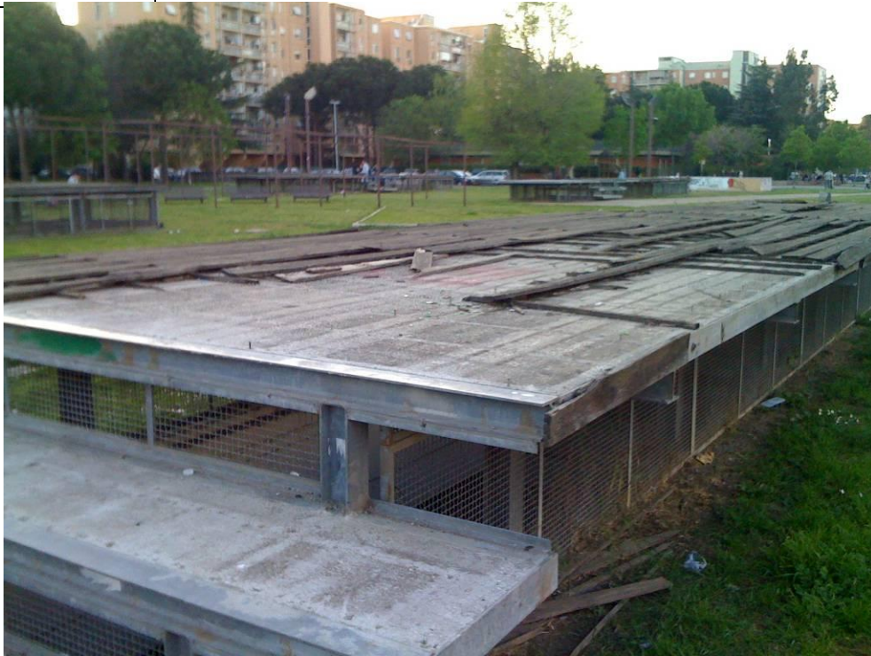
Rivestimenti sfiati garage parco Aldo Tozzetti
